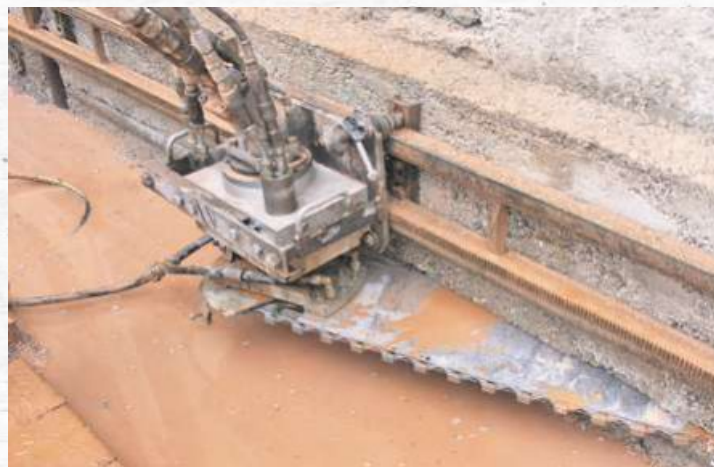
Die hydraulische Jörg-Kettensäge. Foto: Jörg Bausanierung
